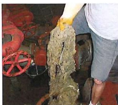
Déchets divers obstruant les réseaux d'assainissement - © G. Jacomet
